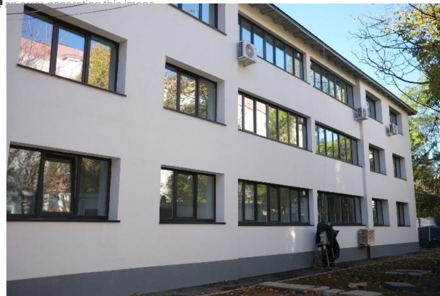
Baltagului nr. 17, sector 5, București, primul proiect finalizat prin Planul Național de Redresare și Reziliență (PNRR) în Capitală, înainte și după consolidare.
