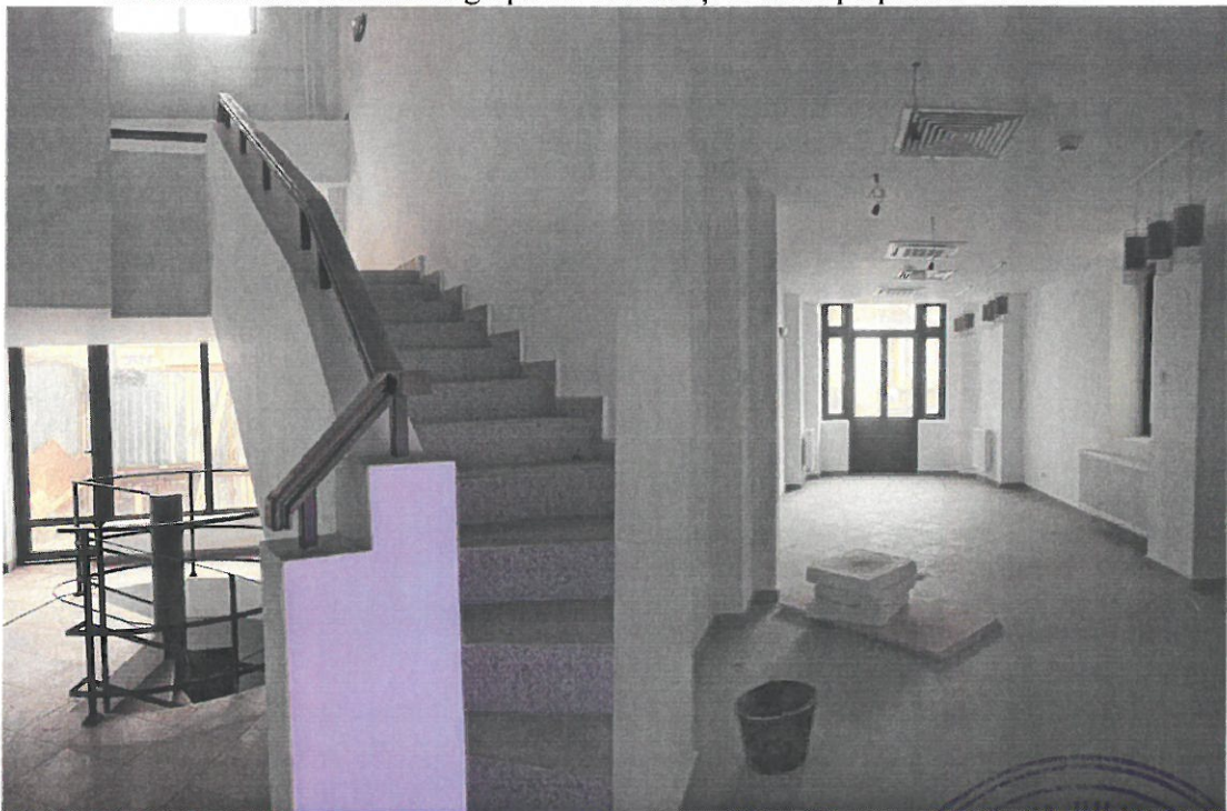
Scările interioare sunt finisate, deasemenea spațiile interioare. Sunt montate corpurile de iluminat, instalația de ventilație și climatizare.
