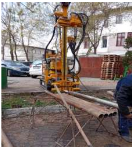
Figura 7. Fotografie din amplasament în timpul realizării forajului geotehnic și cu pământul rezultat în urma forajului
