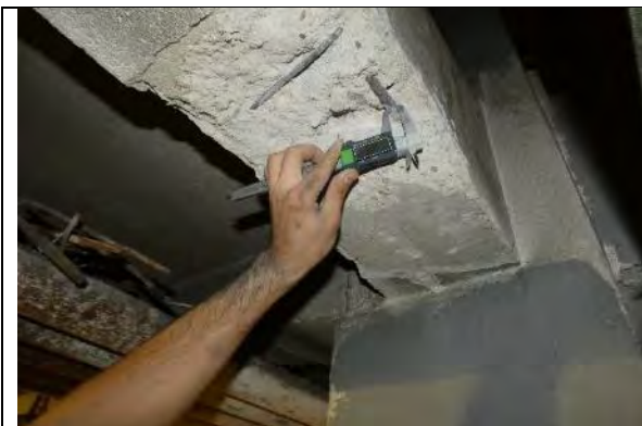
Sondaj GR07 grinda beton armat monolit parter: sectiune transversala 20x55 cm, armare longitudinalala 2 \Phi 12 OB37 la partea inferioara, armare transversala \Phi 6 OB37/20cm;
