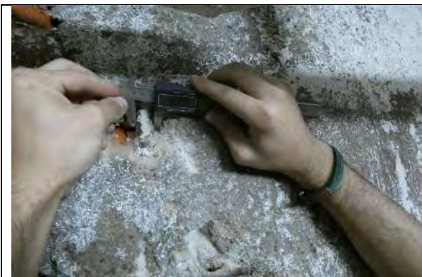
Sondaj ST01 stalp beton armat monolit, subsol: sectiune transversala 70x70cm, armare longitudinala 3 \Phi 20 OB37 pe latura incercata, armare transversala \Phi 8 OB37 /20cm;
