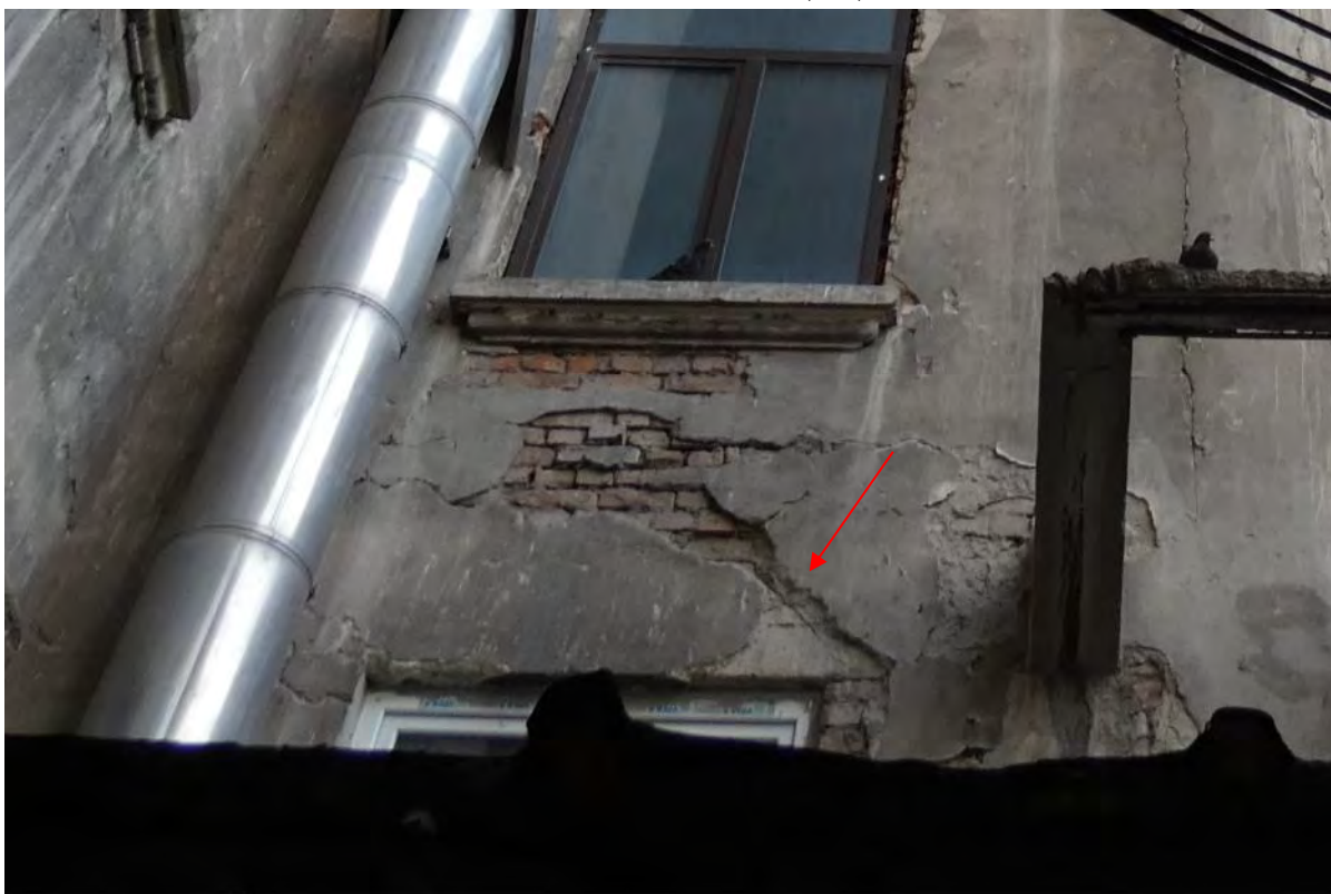
Foto 22 – Cedare locala a grinzii din beton armat
