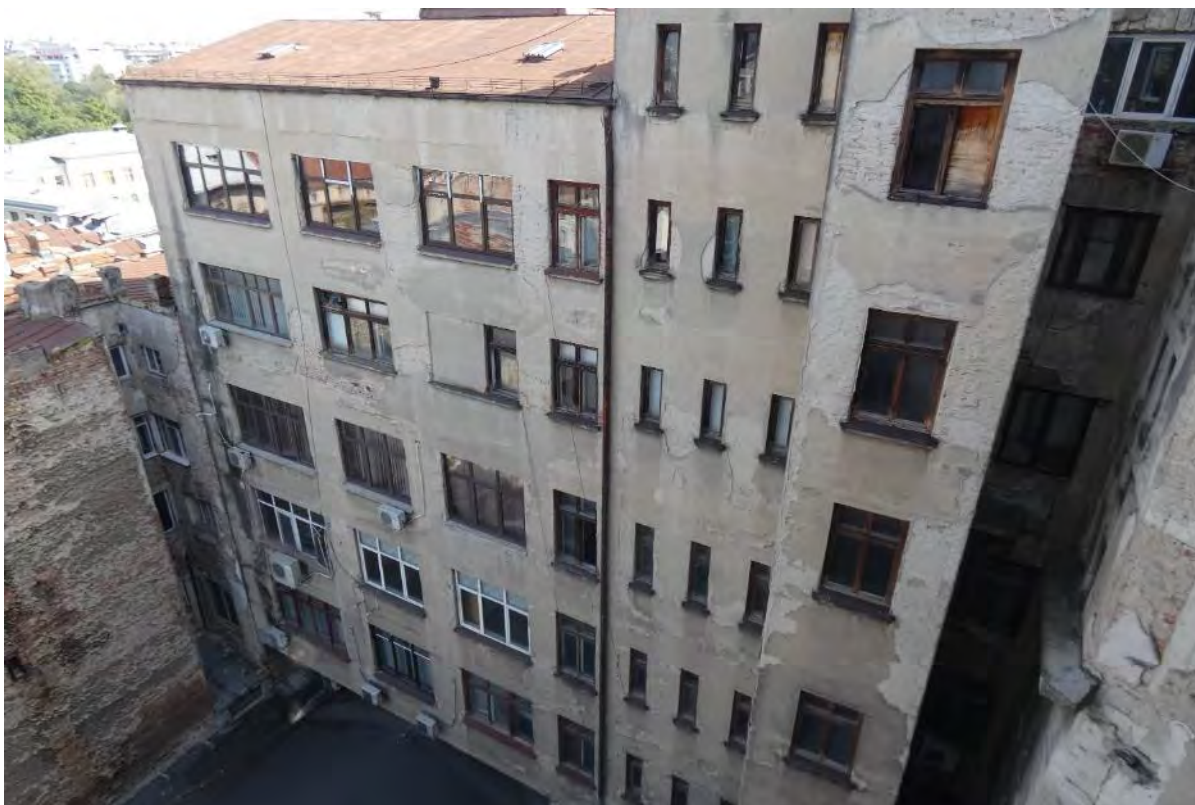
Foto 13 – Curte interioara – vedere de ansamblu spre aripa vest
