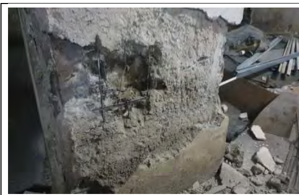
Sondaj ST02 stalp beton armat monolit subsol: sectiune transversala 80x80cm, consolidat dupa cutremurul din 1977 prin dispunerea la colturi de corniere 100x100x80mm si camasuit cu plasa sudata \Phi 4mm;
