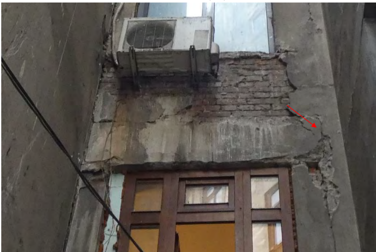
Foto 18 – Fracturi verticale in nodul de cadru
