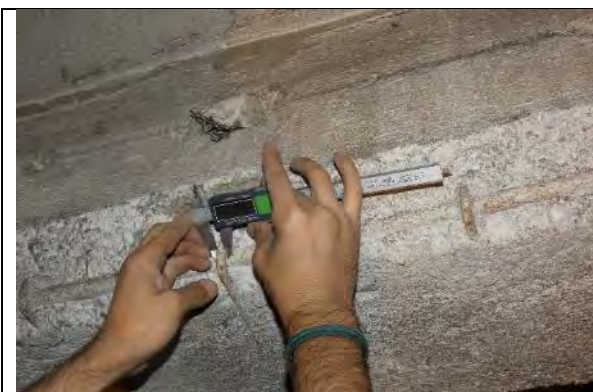
Sondaj GR04 grinda beton armat monolit subsol: sectiune transversala 30x55 cm, armare longitudinala 3 \Phi 18 OB37 la partea inferioara, armare transversala \Phi 8 OB37/25cm;
