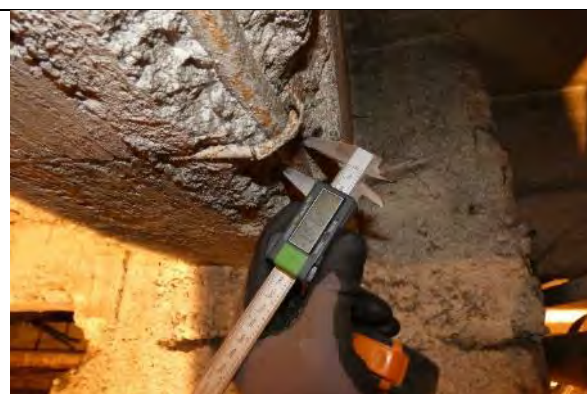
Sondaj GR03 grinda beton armat monolit subsol: sectiune transversala 30x50 cm, armare longitudinala 3 \Phi 20 OB37 la partea inferioara, armare transversala \Phi 8 OB37/20cm;
