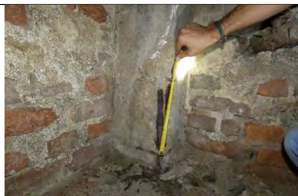
Sondaj ST03 stalp beton armat monolit, subsol: sectiune transversala 70x70cm, armare longitudinala 3 \Phi 20 OB37 pe latura incercata, armare transversala \Phi 8 OB37 /30cm;
