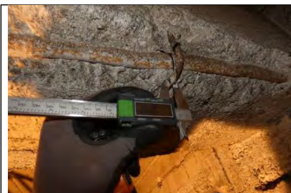
Sondaj GR03 grinda beton armat monolit subsol: sectiune transversala 30x50 cm, armare longitudinala 3 \Phi 20 OB37 la partea inferioara, armare transversala \Phi 8 OB37/20cm;
