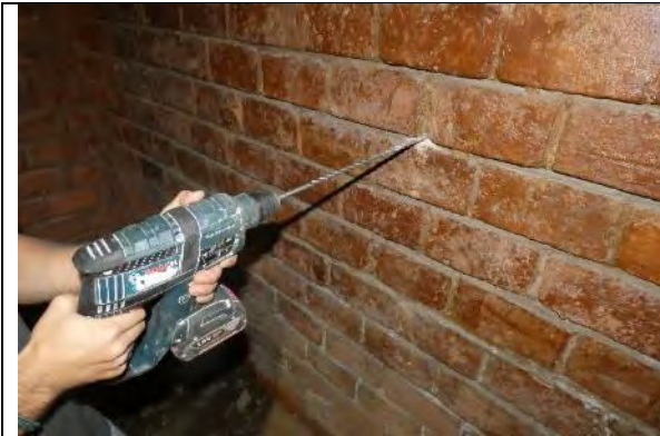
Sondaj PB01: identificare pereti beton subsol
