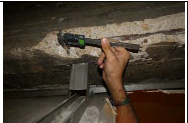
Sondaj GR06 grinda beton armat monolit subsol: sectiune transversala 35x55 cm, armare longitudinalala 3 \Phi 18 OB37 la partea inferioara, armare transversala \Phi 8 OB37/90cm;
