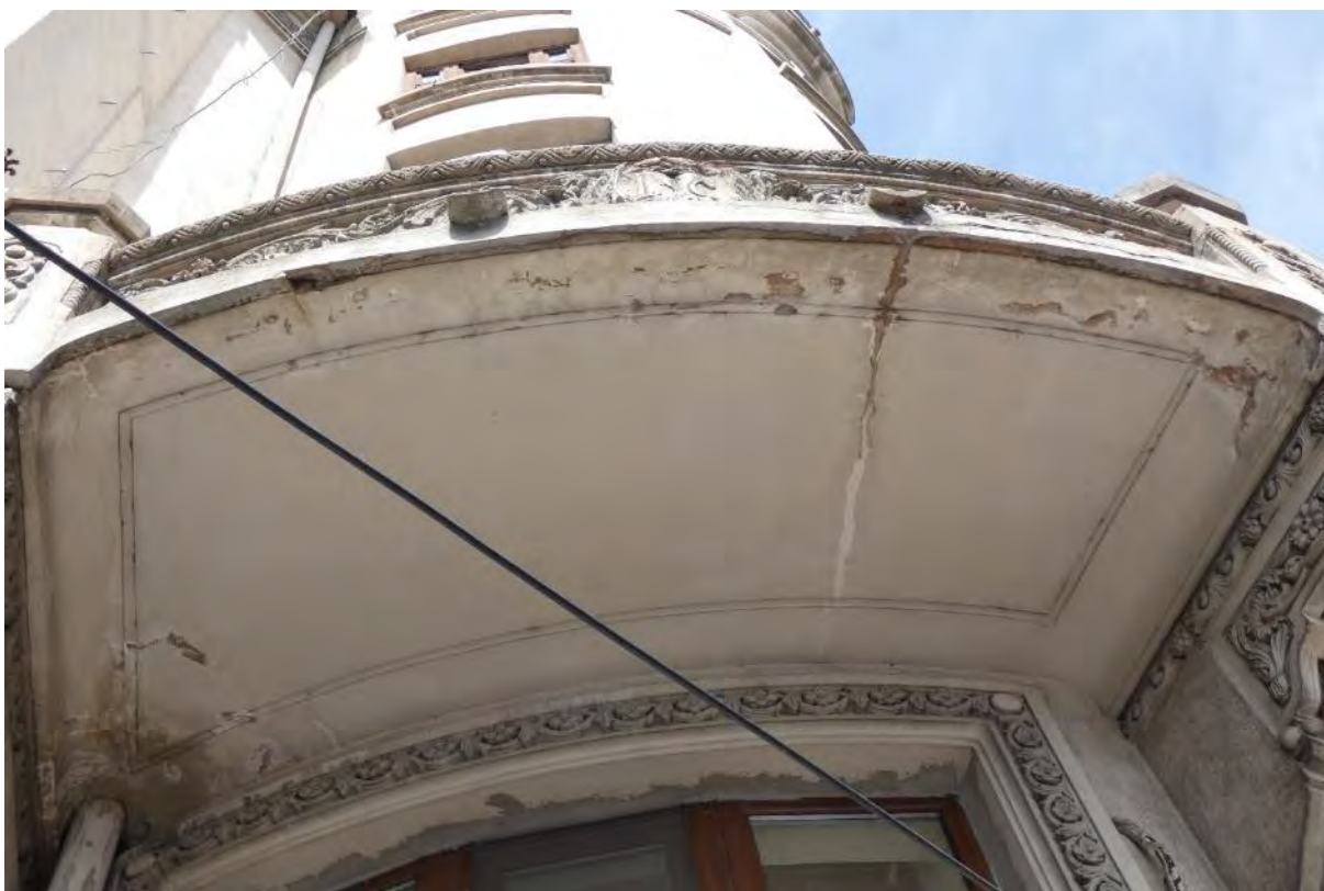
Foto 02 – Crapatura transversala in placa balconului din dreptul peretilor circulari. Tencuiala si zugraveli degradate. Infiltratii de umiditate
