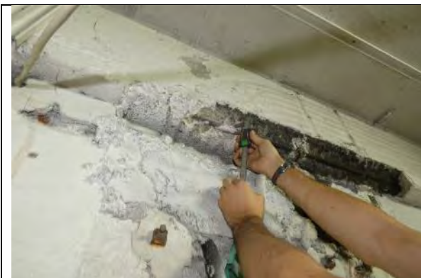
Sondaj GR02 grinda beton armat monolit subsol: sectiune transversala 30x55 cm, armare longitudinala 3 \Phi 20 OB37 la partea inferioara, armare transversala \Phi 8 OB37/20cm;
