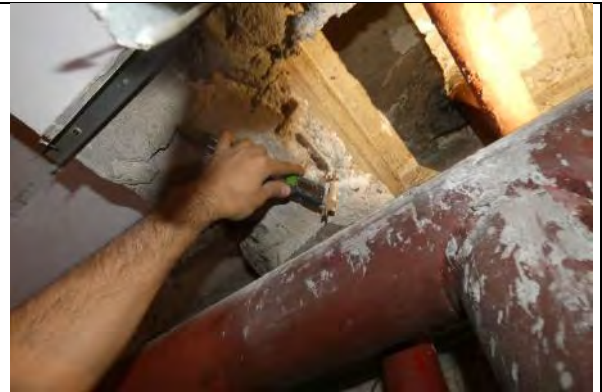
Sondaj GR05 grinda beton armat monolit subsol: sectiune transversala 30x45 cm, armare longitudinalala 3 \Phi 14 OB37 la partea inferioara, armare transversala \Phi 8 OB37/15cm;
