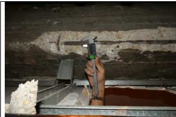
Sondaj GR06 grinda beton armat monolit subsol: sectiune transversala 35x55 cm, armare longitudinalala 3 \Phi 18 OB37 la partea inferioara, armare transversala \Phi 8 OB37/90cm;
