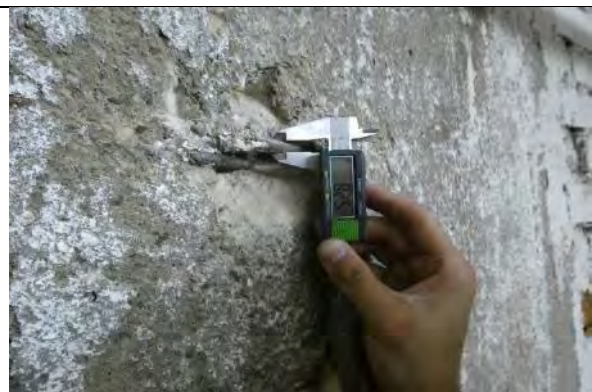
Sondaj ST01 stalp beton armat monolit, subsol: sectiune transversala 70x70cm, armare longitudinala 3 \Phi 20 OB37 pe latura incercata, armare transversala \Phi 8 OB37 /20cm;
