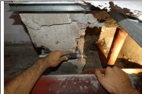
Sondaj GR05 grinda beton armat monolit subsol: sectiune transversala 30x45 cm, armare longitudinalala 3 \Phi 14 OB37 la partea inferioara, armare transversala \Phi 8 OB37/15cm;
