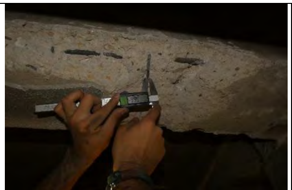
Sondaj GR07 grinda beton armat monolit parter: sectiune transversala 20x55 cm, armare longitudinalala 2 \Phi 12 OB37 la partea inferioara, armare transversala \Phi 6 OB37/20cm;
