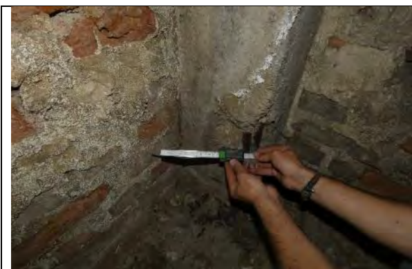
Sondaj ST03 stalp beton armat monolit, subsol: sectiune transversala 70x70cm, armare longitudinala 3 \Phi 20 OB37 pe latura incercata, armare transversala \Phi 8 OB37 /30cm;
