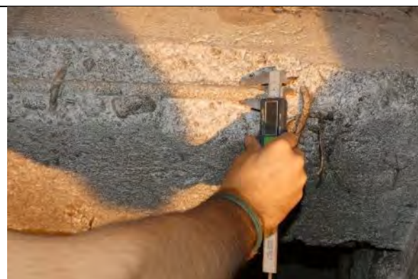
Sondaj GR04 grinda beton armat monolit subsol: sectiune transversala 30x55 cm, armare longitudinala 3 \Phi 18 OB37 la partea inferioara, armare transversala \Phi 8 OB37/25cm;
