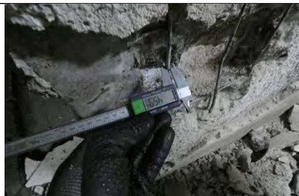
Sondaj ST02 stalp beton armat monolit subsol: sectiune transversala 80x80cm, consolidat dupa cutremurul din 1977 prin dispunerea la colturi de corniere 100x100x80mm si camasuit cu plasa sudata \Phi 4mm;
