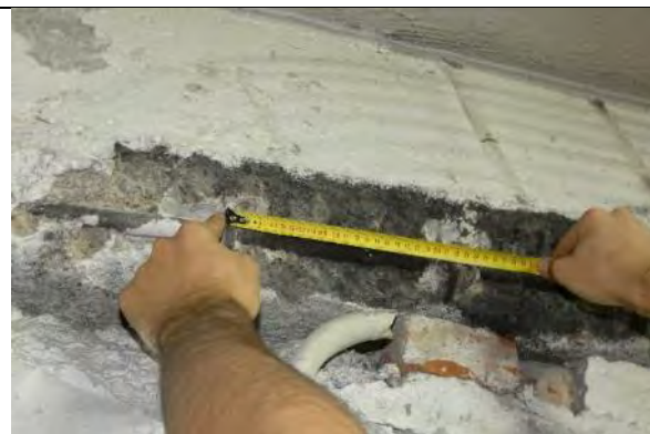
Sondaj GR02 grinda beton armat monolit subsol: sectiune transversala 30x55 cm, armare longitudinala 3 \Phi 20 OB37 la partea inferioara, armare transversala \Phi 8 OB37/20cm;
