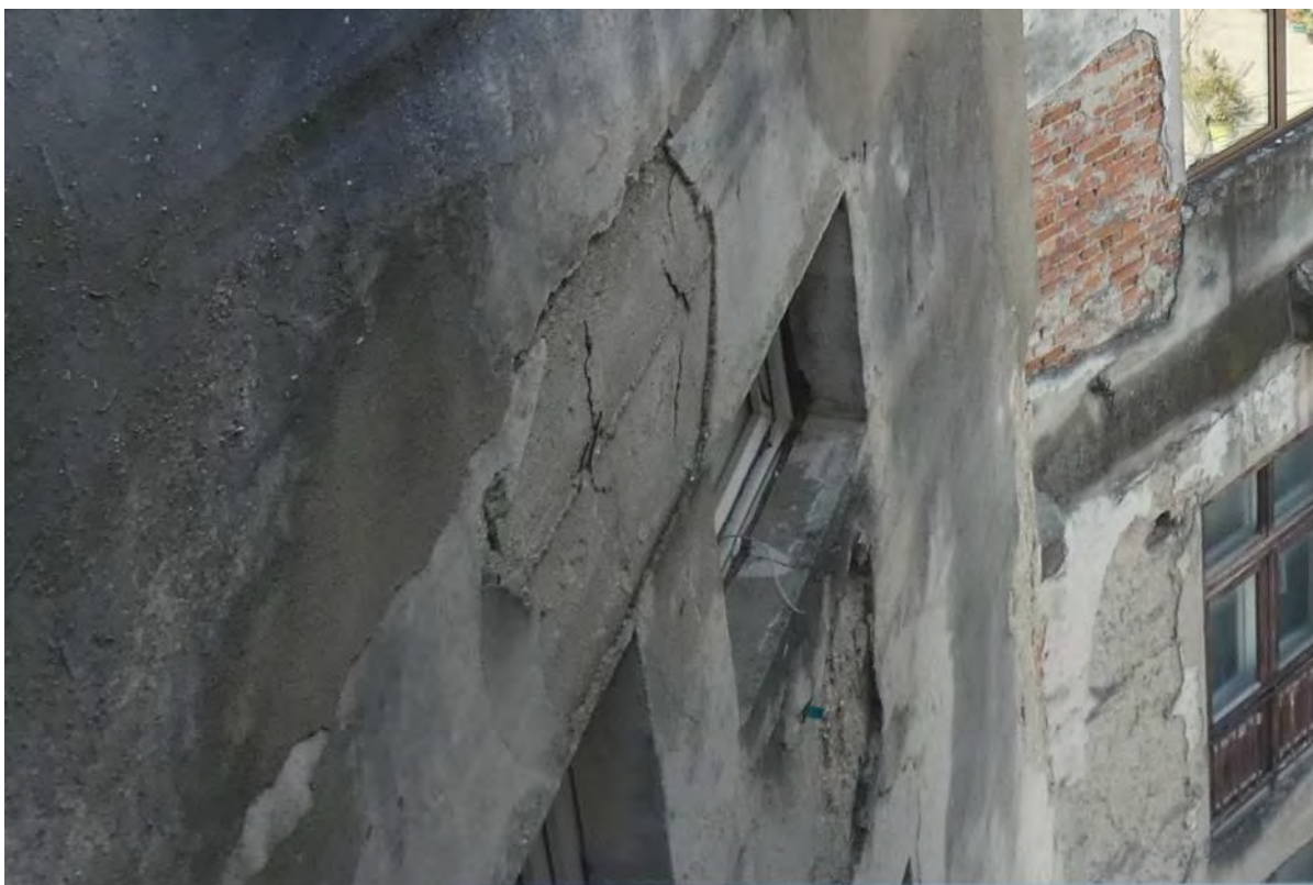
Foto 35 – Fracturi in dreptul nodului
