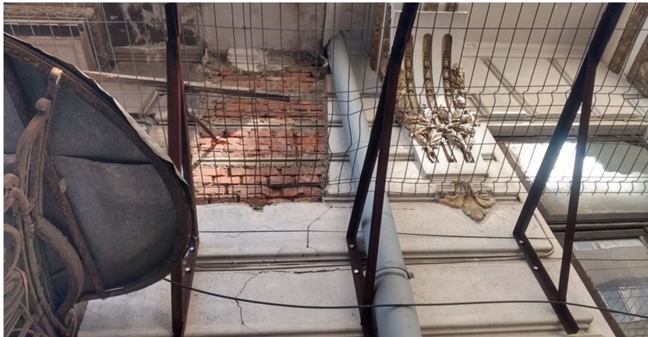
Perete exterior cu tencuiala crapata si cazuta, caramida vizibila
