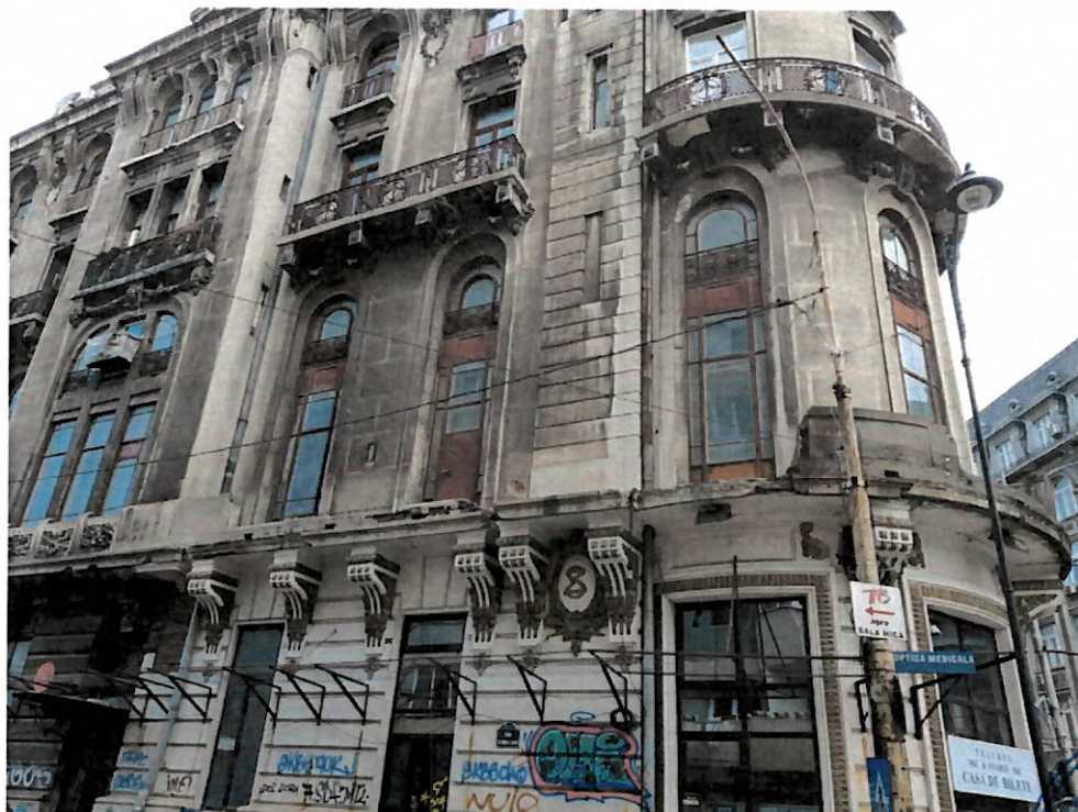
Foto 1 – fatada dinspre strada Jean Louis Calderon (balustrada lipsa balcon, tamplarie corodată, vandalizare)
