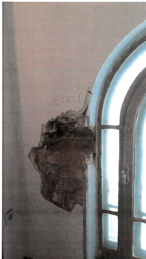
Foto 32 – etaj 1 - prelevare proba zidarie
