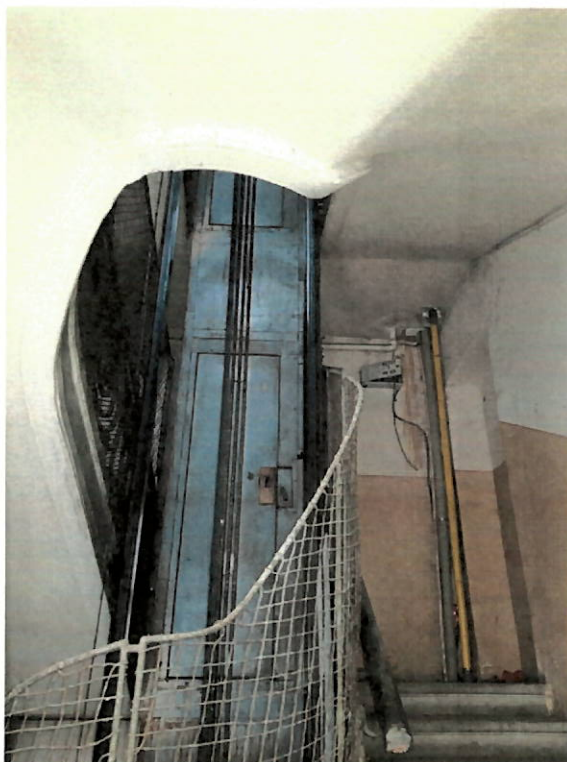
Foto 24 – casa scarii spre apartamente, zona lift
