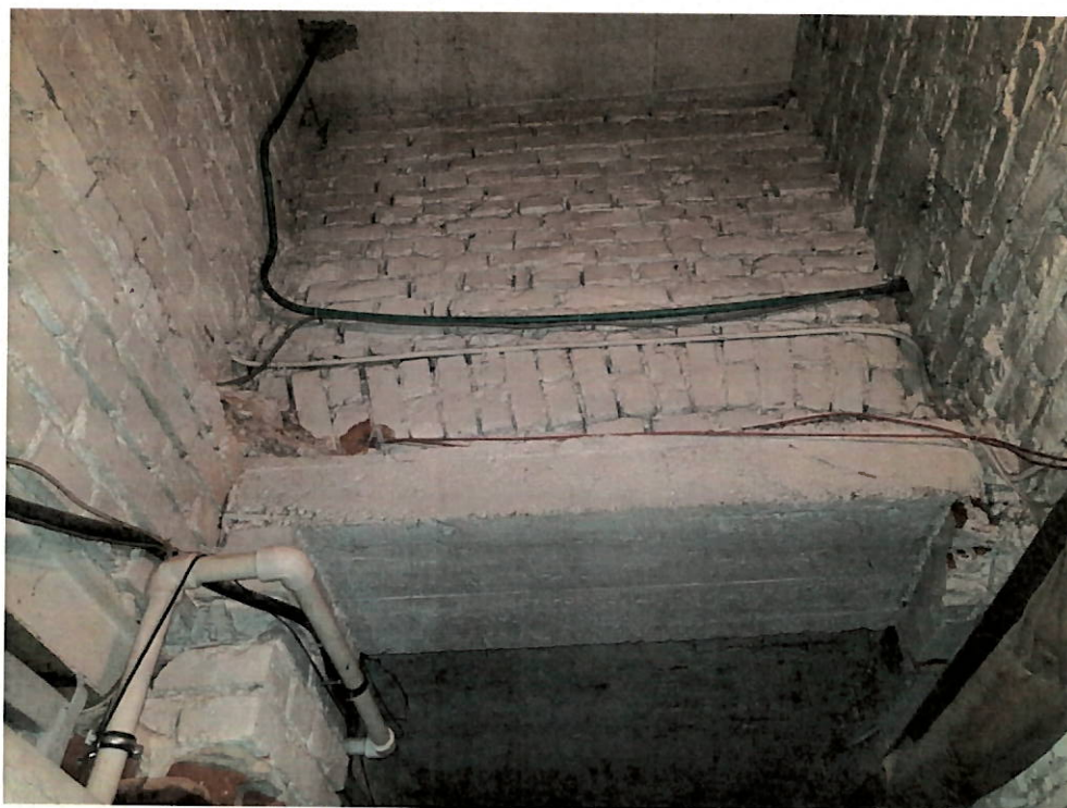
Foto 11 – subsol, culoar central (buiandrug beton, interventie ulterioara)
