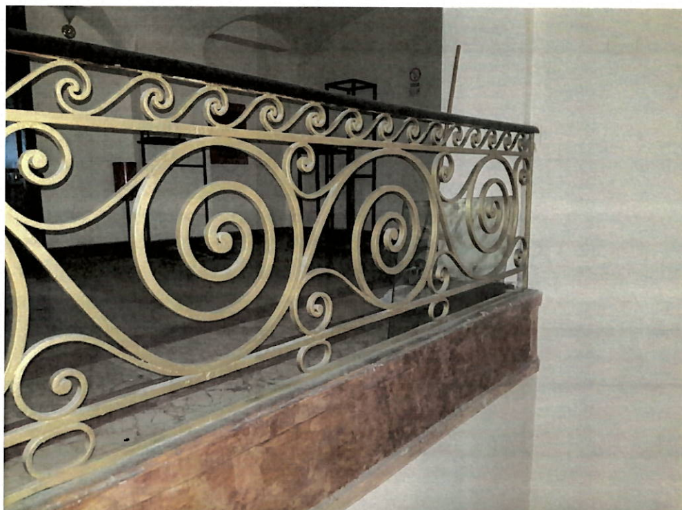
Foto 21 – scara monumentală (balustradă metalică)
