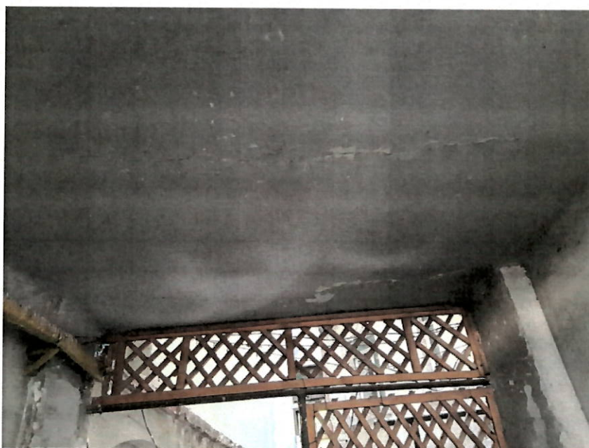
Foto 9 – culoar acces auto catre curtea interioara (crapatura in tavan)
