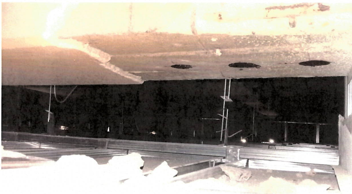
Foto 34 – planseu peste parter (zona atelier) ; prim plan : grinda principală 50cm de sub scena, plan secund : grinzi secundare planseu peste camera atelier (cadastru, camera 6)
