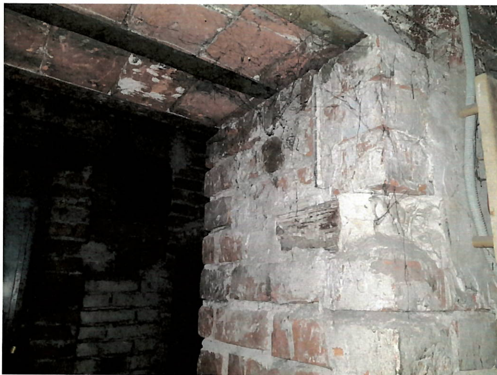
Foto 12 – subsol (buiandrug original - zidarie si metal)
