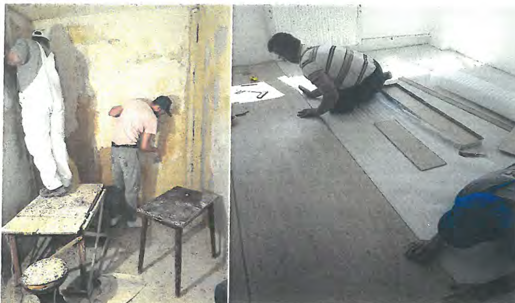
Reparații generale și de renovare
